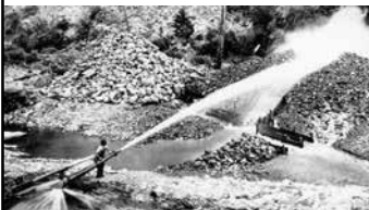
Monitores hidráulicos num depósito aluvionar seco de ouro, Califórnia, USA, cerca de 1860
