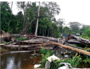
Chantier en lit sec et barrage, Danze
