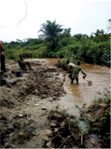
Chantier de sous-berge
